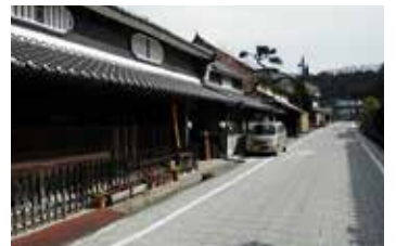
▲電線類地中化地区（岡）
